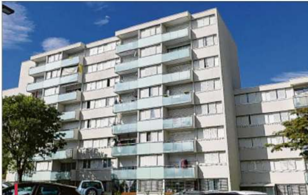
Désormais, 4 000 à 5 000 familles de la résidence de La Soude, dans le 9 e arrondissement, bénéficient de ce gaz vert, acheminé depuis l'usine de méthanisation de Sormiou. /PHOTO DR
