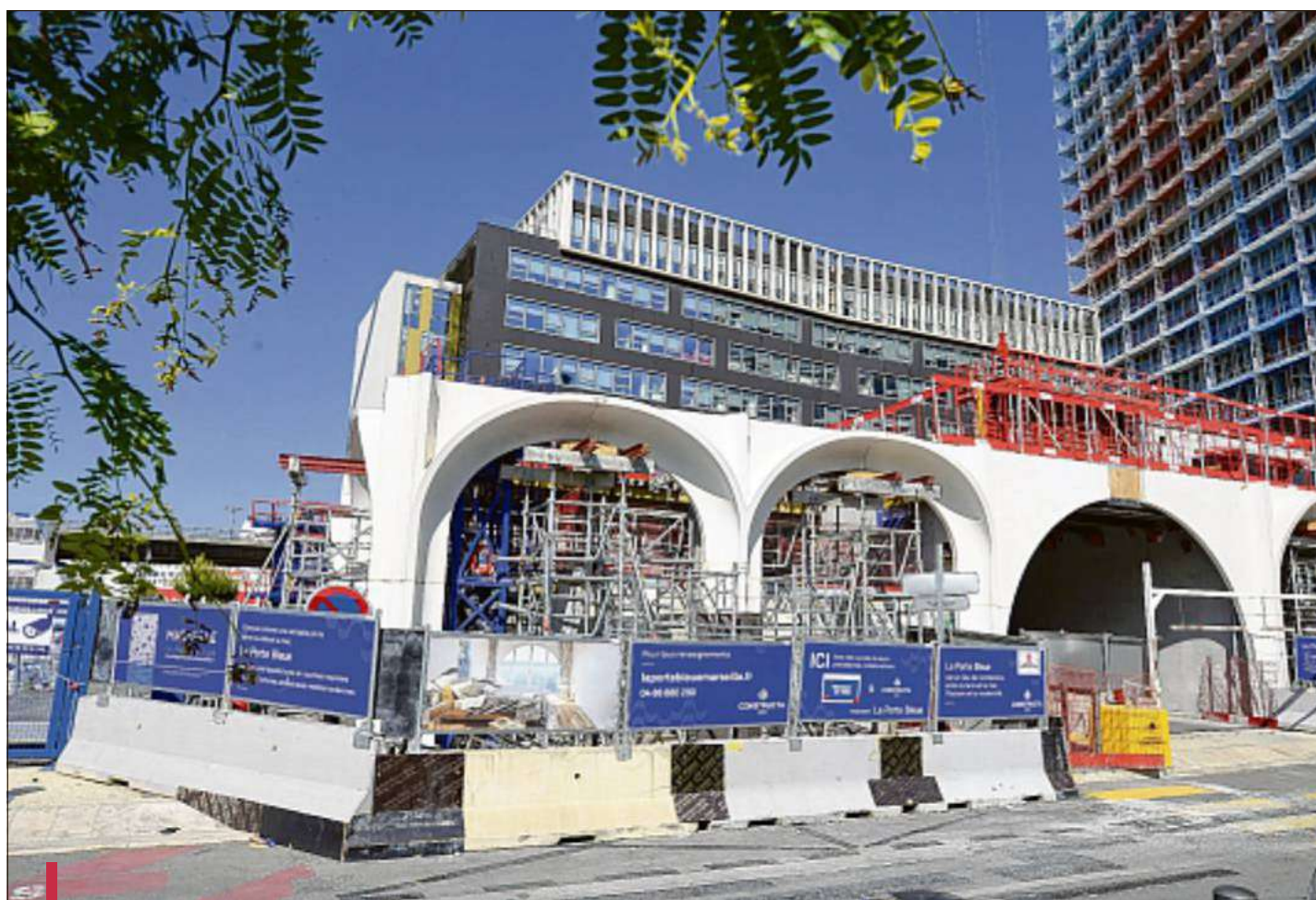
Les éléments en béton blanc sont emboîtés avec une extrême précision sur le chantier, au pied de la tour La Marseillaise. / PHOTOS FRANCK PENNANT
