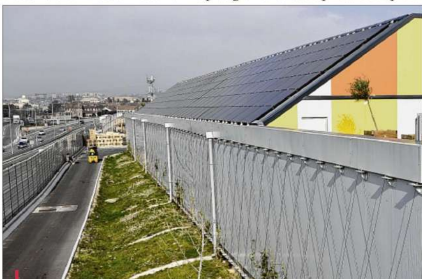
Les nouveaux bâtiments installés le long de la rocade L2 sont déjà équipés de panneaux photovoltaïques.
