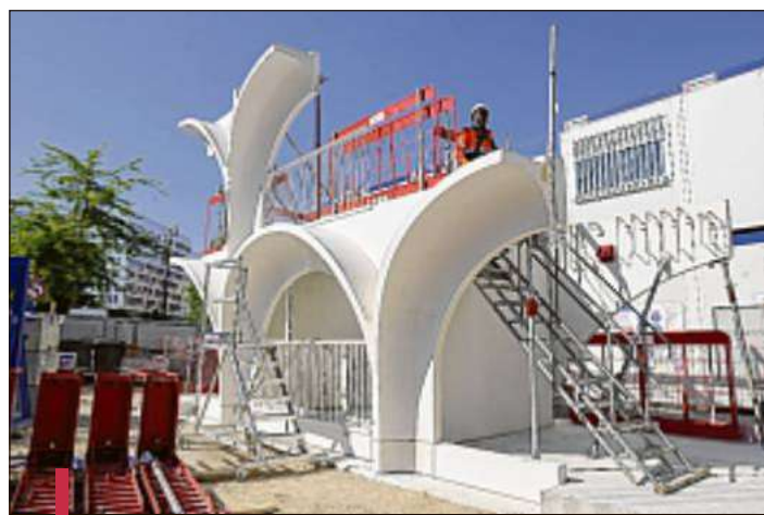
Après avoir été vérifiées sur la zone de prototypage, les pièces fabriquées à Aubagne rejoignent la structure même du bâtiment, portées par des "crabs", sortes de "chaises à bras" à vérins hydrauliques.
