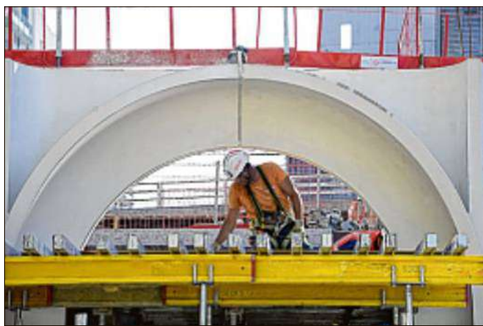
Après avoir été vérifiées sur la zone de prototypage, les pièces fabriquées à Aubagne rejoignent la structure même du bâtiment, portées par des "crabs", sortes de "chaises à bras" à vérins hydrauliques.
