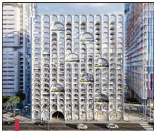
Les voûtes sont fabriquées avec du béton utilisant des résidus recyclés. / PIETRI ARCHITECTES
