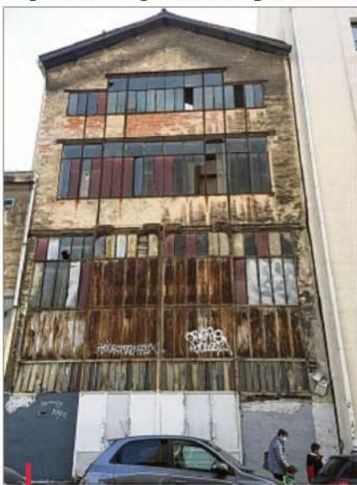
Entre Saint-Victor et la rue d'Endoume, l'ancienne ferronnerie Piana pourrait fédérer tout un quartier. /PHOTO L.M.
