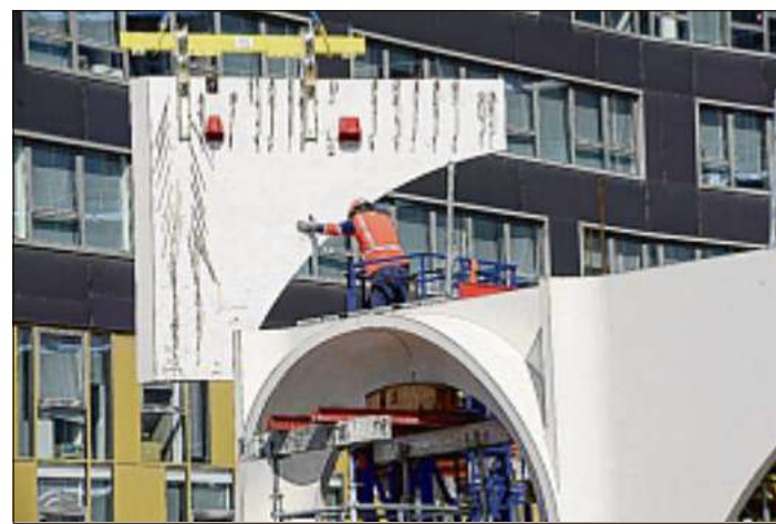
Après avoir été vérifiées sur la zone de prototypage, les pièces fabriquées à Aubagne rejoignent la structure même du bâtiment, portées par des "crabs", sortes de "chaises à bras" à vérins hydrauliques.
