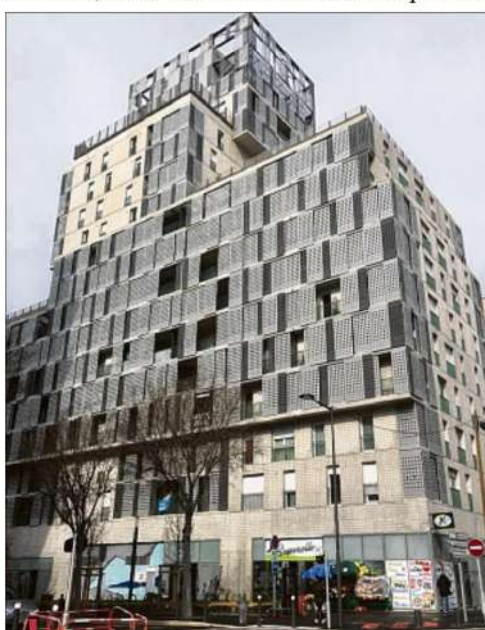
Livré fin 2019, 2 e Élément aligne 178 logements sur 17 étages, entre les rues Mirabeau, Peyssonnel et de Ruffi.
