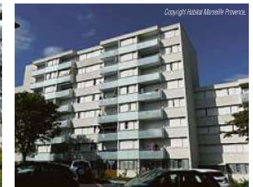
Copyright Habitat Marseille Provence
