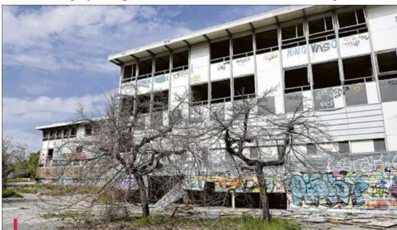
L'ancien collège Louis-Armand n'est plus qu'une friche de près de 2 hectares qu'il faudra désamianter et démolir pour que s'ouvre "tout le champ des possibles" que souhaitent développer ici les élus PM Mathilde Chaboche et Yannick Ohanessian. /PHOTOS DAVID ROSSI
