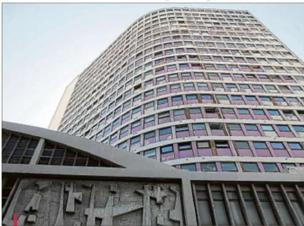
Dessinée par l'architecte Claude Gros, la façade incurvée en forme d'aile d'avion, a été conçue pour affronter des épisodes cévenols avec des vents soufflant jusqu'à 180 km/h. /PHOTO VALÉRIE VREL
