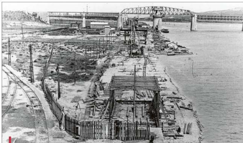
La construction des quais du port de Caronte, dans le bassin Martigues Port-de-Bouc.
