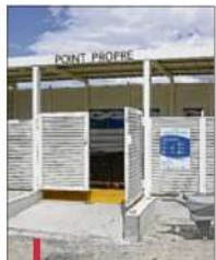
Le port vise la certification "Port propre" avec cette mini-déchetterie.
