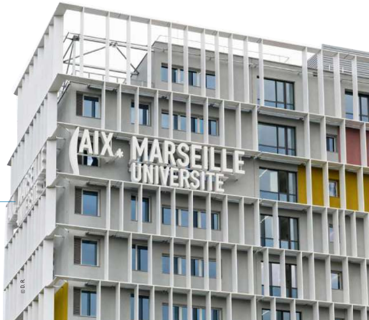
Le TPR2, Immeuble de grande hauteur (IGH), accueille des laboratoires de recherche ainsi que l'administration du campus.
