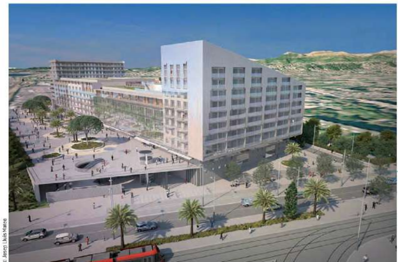
A Nice, Newton Offices a acquis en Vefa la totalité des surfaces de bureaux, 3 700 m 2 sur cinq niveaux, du programme « L'Avant-Scène » de Quartus, dans le Grand Arénas.
