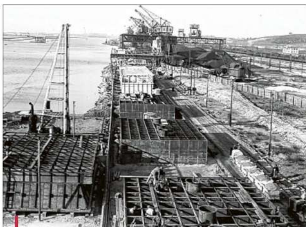
L'établissement maritime de Caronte s'est développé au fil des années. Ici lors de l'extension des quais à l'ouest de la zone, en 1932.
