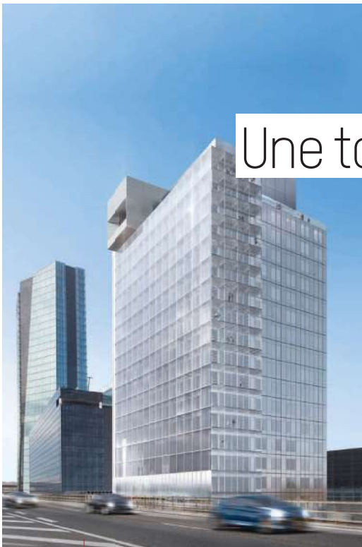
La future tour Mirabeau vue depuis le viaduc de la Joliette.
