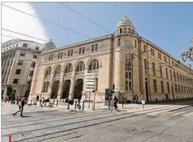
Cette superbe rénovation met en valeur les lignes élégantes du bâtiment, notamment sa façade dont Huot a adouci les angles en les dotant de deux tourelles surmontées d'un dôme. /PHOTOS VALÉRIE VREL
